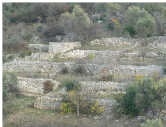
Figura 11 – Muretti a secco lunga il Torrente Baronale in agro di Bari
