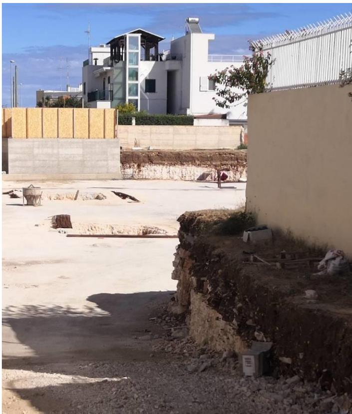
Affioramento di Calcarea di Bari, rilevato nei pressi di un cantiere tra via Udine angolo via Suor Maria Lucchesi, l'ammasso calcareo si presenta stratificato e fratturato e ricoperto da uno strato di 0,5m – 0,8m di terreno agrario e "terra rossa".
